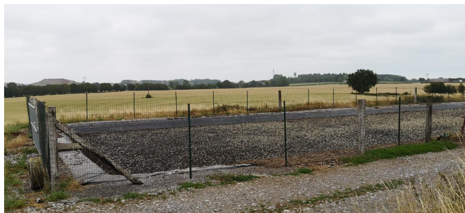
Figure 2 : Photo de la fosse géomembrane clôturée du Gaec du Fort Manteau
